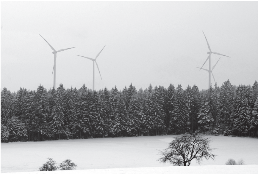
Abb. 1: Windenergieanlagen im Windpark Nordschwarzwald bei Simmersfeld. Foto: Jürgen Trautner
